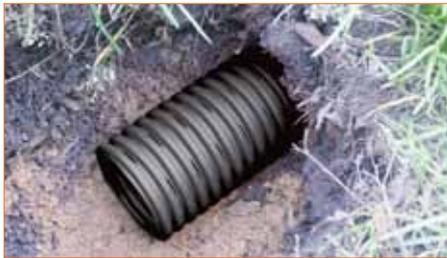
**ДРЕНАЖ** – это система подземных каналов, называемых дренами, посредством которых осуществляется отвод от строительных сооружений грунтовой воды и понижение ее уровня, а также осушение земель под выращивание сельскохозяйственной продукции. Вода из дренажной сети выводится за
